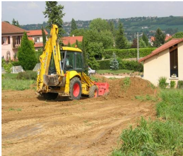
Figure 4.1 : Décapage de la terre végétale
