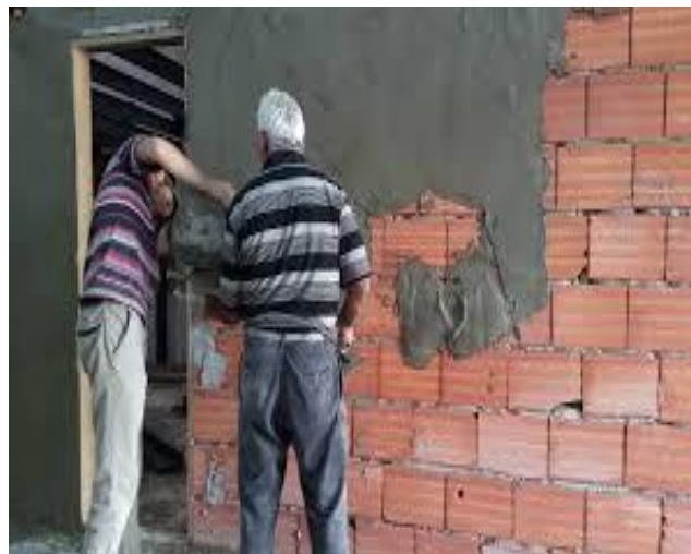
Figure 5.4 : Enduit au ciment sur murs
