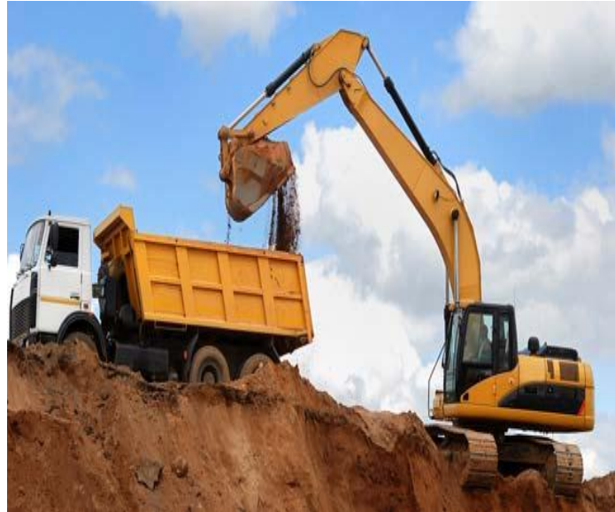
Figure 4.5 : Déblais non réutilisés et évacués à la décharge publique (DP)
