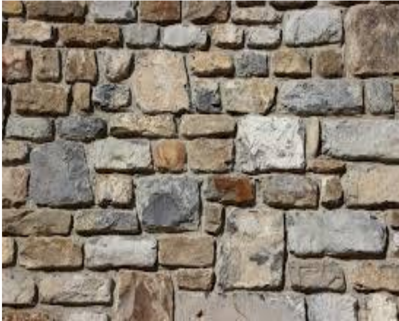
Figure 5.1 : Maçonnerie de moellons
