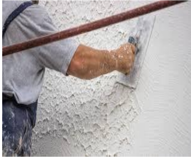
Figure 5.3 : Enduit au plâtre sur murs
