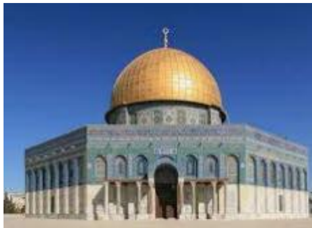
Figure 3.28 : Exemple d'une coupole
