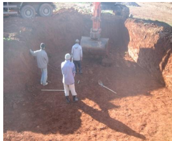
Figure 4.6 : Fouilles en pleine masse ou en excavation
