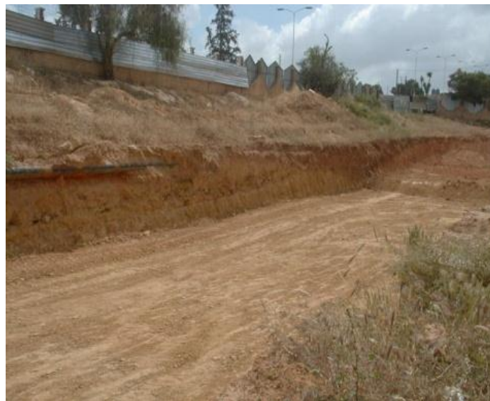
Figure 4.2 : Nivellement de terrain
