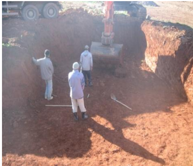
Figure 4.3 : Déblai d'un terrain
