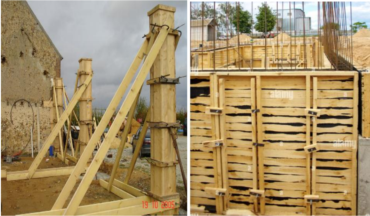
Figure 6.1 : Coffrage en bois
