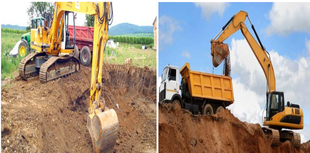
Figure 4.11 : Transport de quantité du sol foisonnée vers DP
