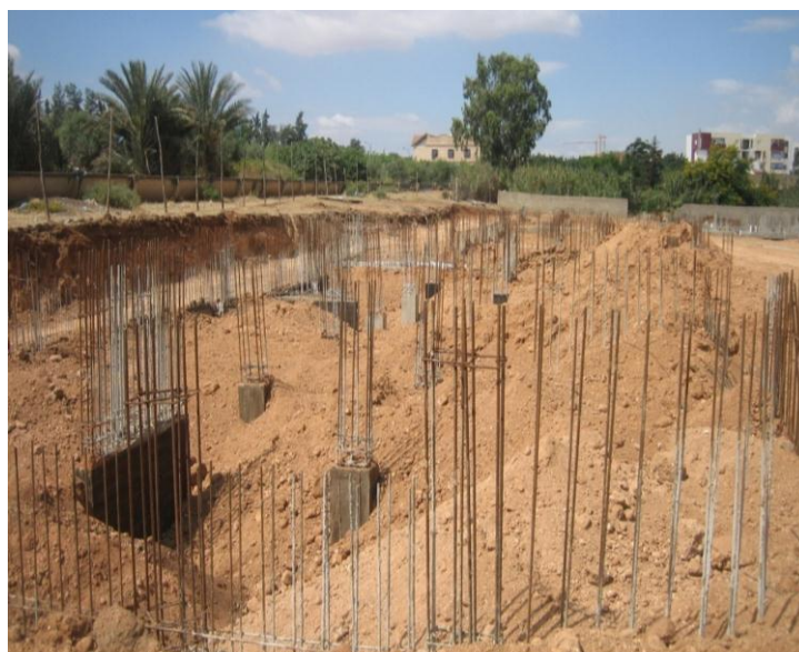
Figure 4.4 : Remblai d'un terrain
