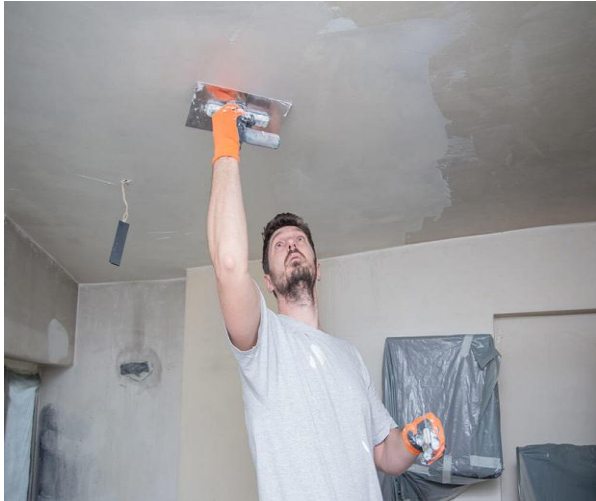
Figure 5.2 : Enduit au plâtre sous plafonds
