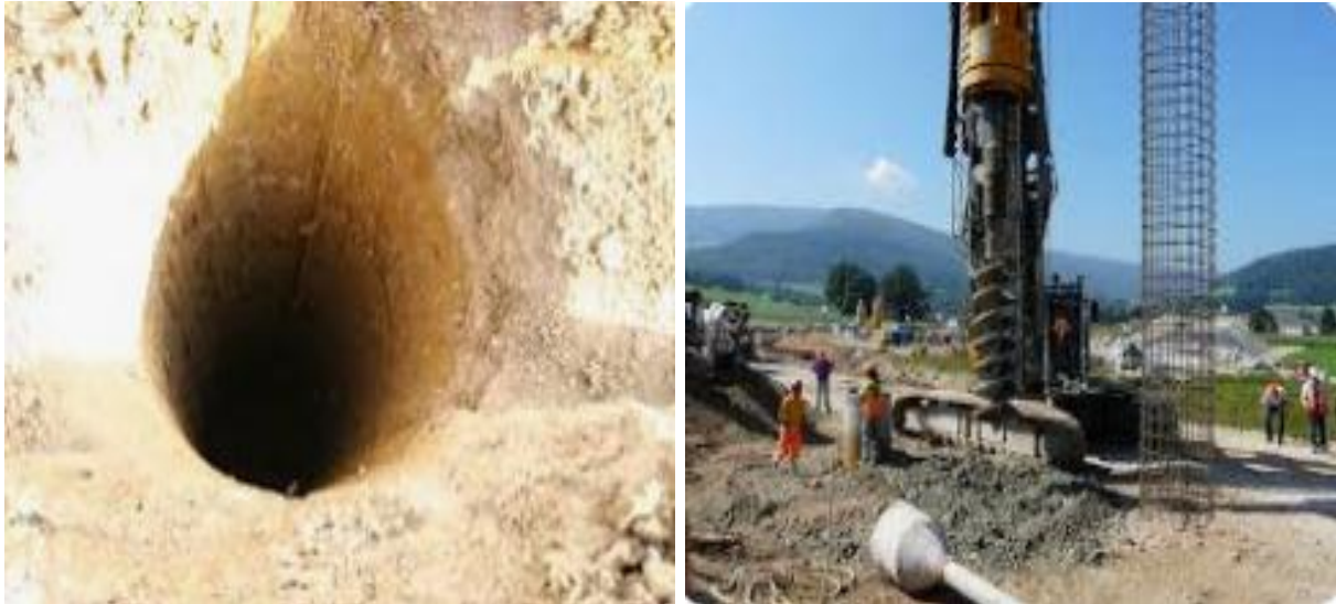
Figure 4.10 : Fouilles en pieux
