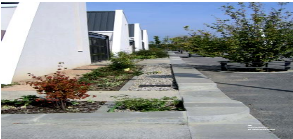
Figure 4.8: Exemple d'une tranchée d'infiltration.
