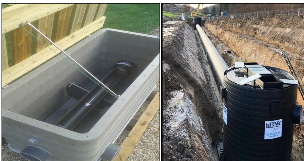
Figure 2.10: Exemples de déversoir d'orage.
