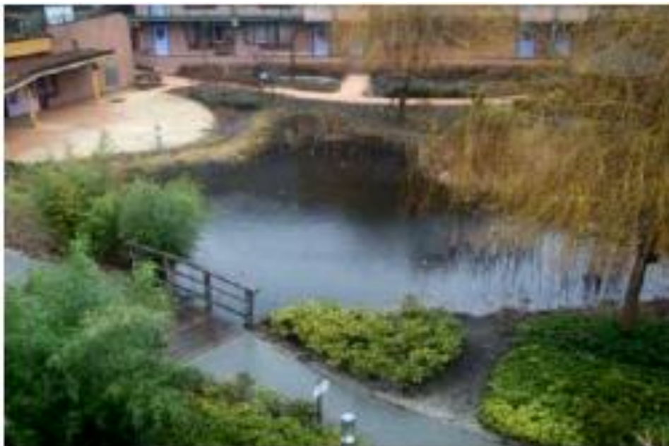
Figure 4.6: Exemple d'un bassin d'infiltration.
