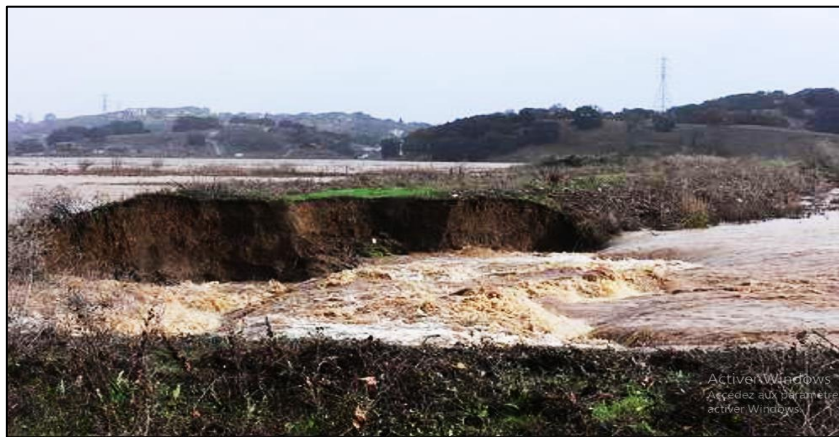
Figure 3.6: Rupture d'une digue à Novato (Californie) en 2005.
