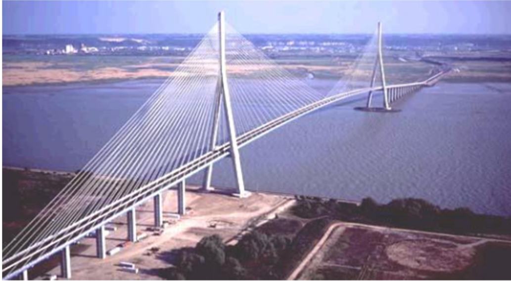
Figure 2.29. Pont de Normandie: le fonctionnement est simple; les haubans relient le tablier aux 2 pylônes.
