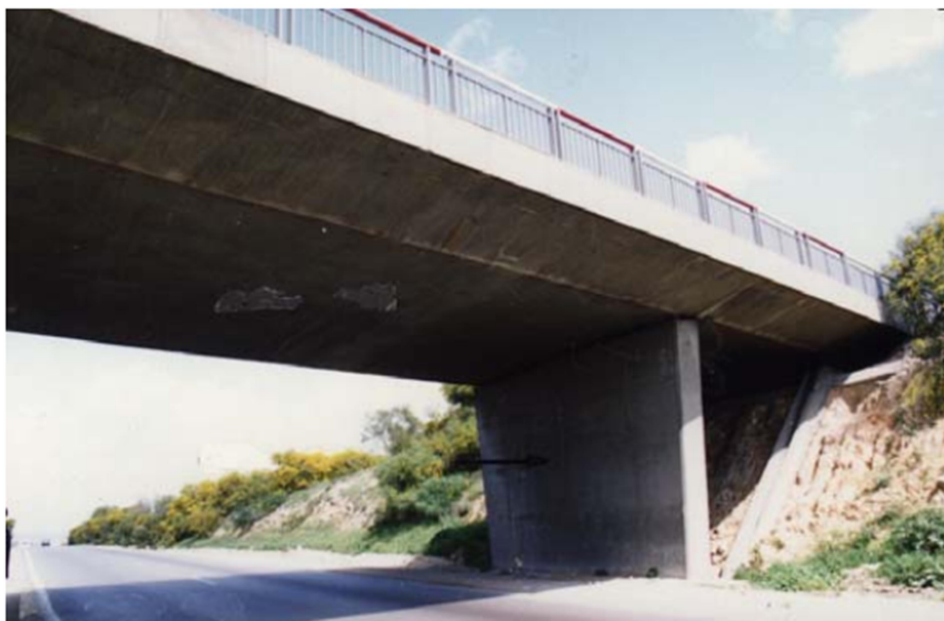
Figure 1.5. Pont en béton armé.
