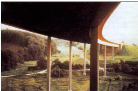
Figure 2.18. Piles non proportionnelles au tablier. Une impression de fragilité chez l'observateur.
