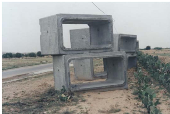
Figure 3.6. Dalots préfabriqués prêts pour être installés.
