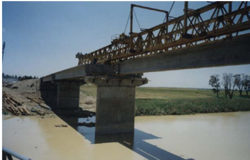
Figure 1.48. Mise en place à l'aide du lanceur des poutres précontraintes préfabriquées constituant le tablier du pont.
