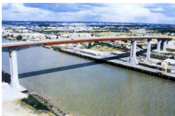
Figure 2.23. Pont qui ne ferme pas la vision du canal.
