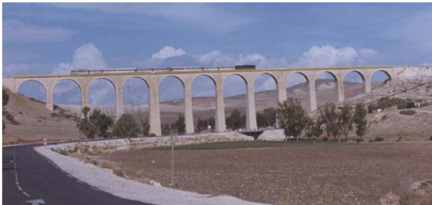
Figure 1.4. Pont en maçonnerie construit en voûte.
