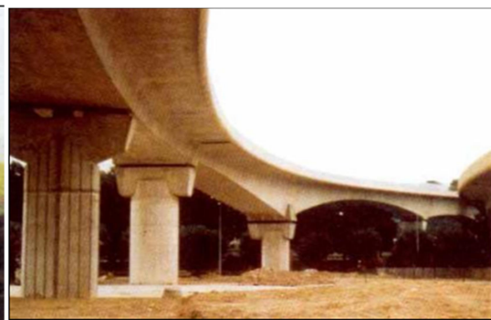
Figure 2.19. Piles proportionnelles au tablier. Une impression de sécurité chez l'observateur.
