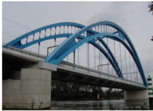
Figure 1.38. Bow-string moderne avec arcs métalliques.
