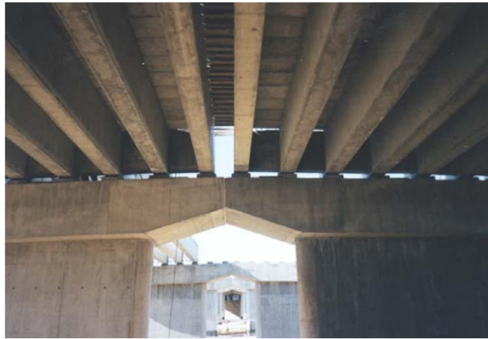
Figure 1.6. Vue du dessous d'un tablier d'un pont à poutres en béton précontraint.
