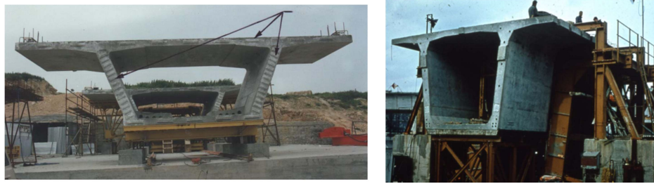
Figure 3.23. Caisson mono-tubulaire exécuté sur le chantier.
