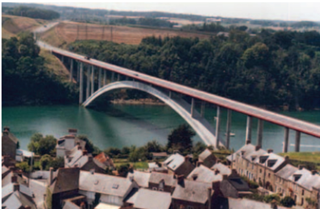
Figure 1.16. Pont à tablier supérieur.
