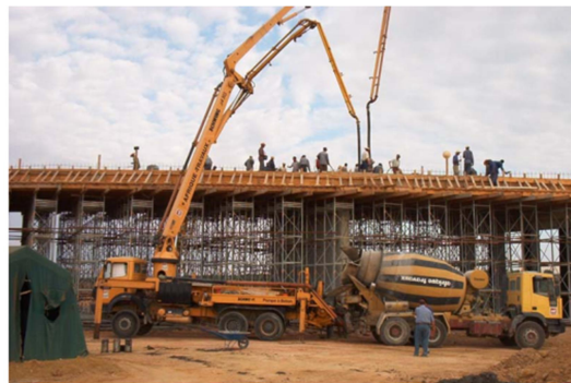
Figure 1.46. Pont dalle coulé sur échafaudage au sol.
