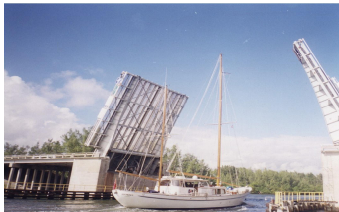
Figure 1.11. Pont basculant.
