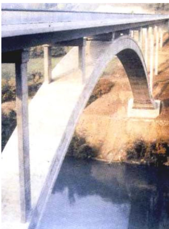
Figure 2.25. Pont en arc bien réussi.
