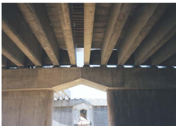
Figure 3.8. Pont à poutres.
