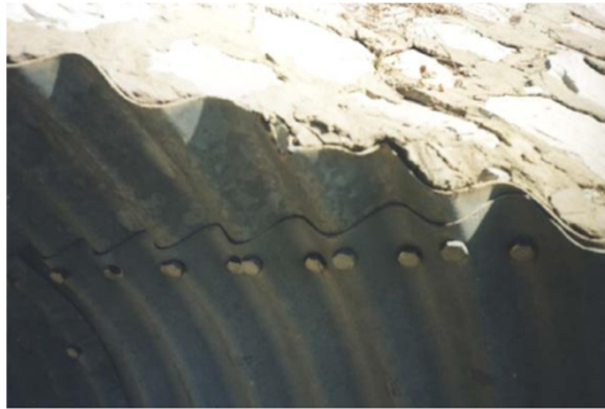
Figure 3.5. Tôle ondulé d'une buse souple connectée par des boulons.
