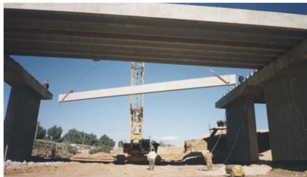
Figure 1.47. Mise en place d'une poutre préfabriquée sur le pont à poutres.
