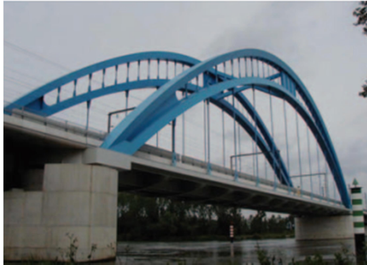
Figure 1.17. Pont à tablier inférieur.
