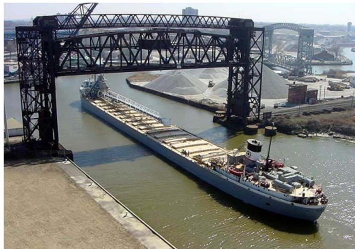
Figure 1.10. Pont levant.
