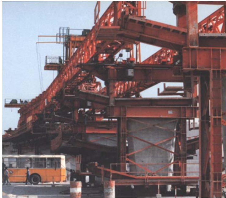
Figure 1.50. Ponts construits sur cintres autoporteurs.
