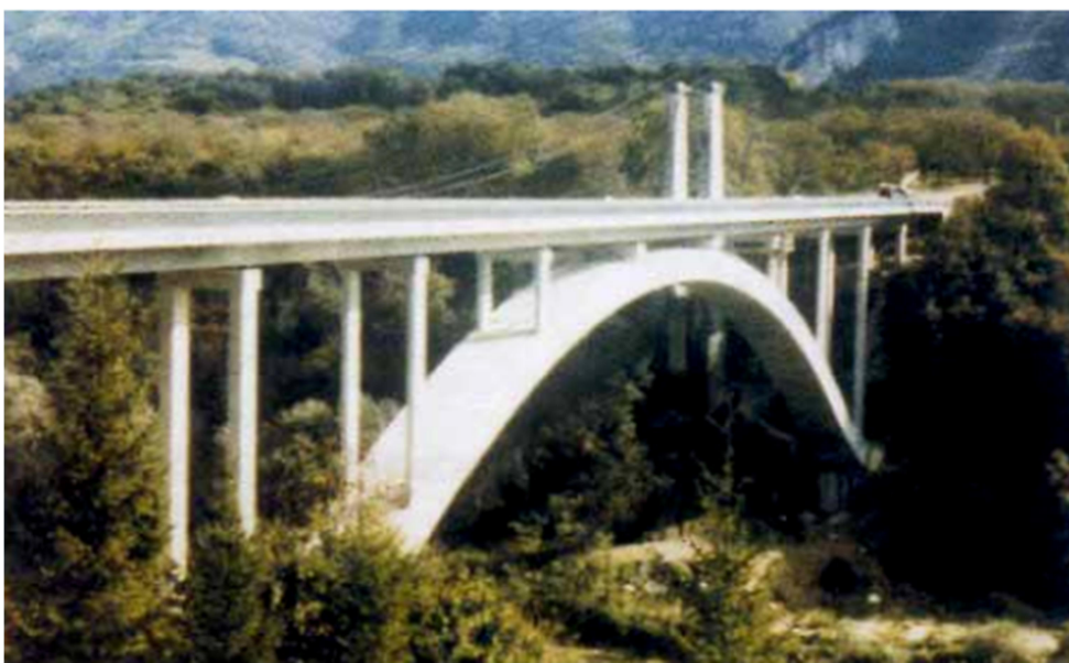
Figure 3.20. Pont en arc.
