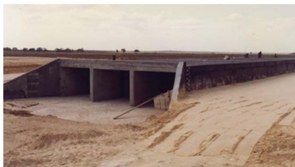
Figure 3.7. Dalot triple coulés sur place, en cours d'exécution.
