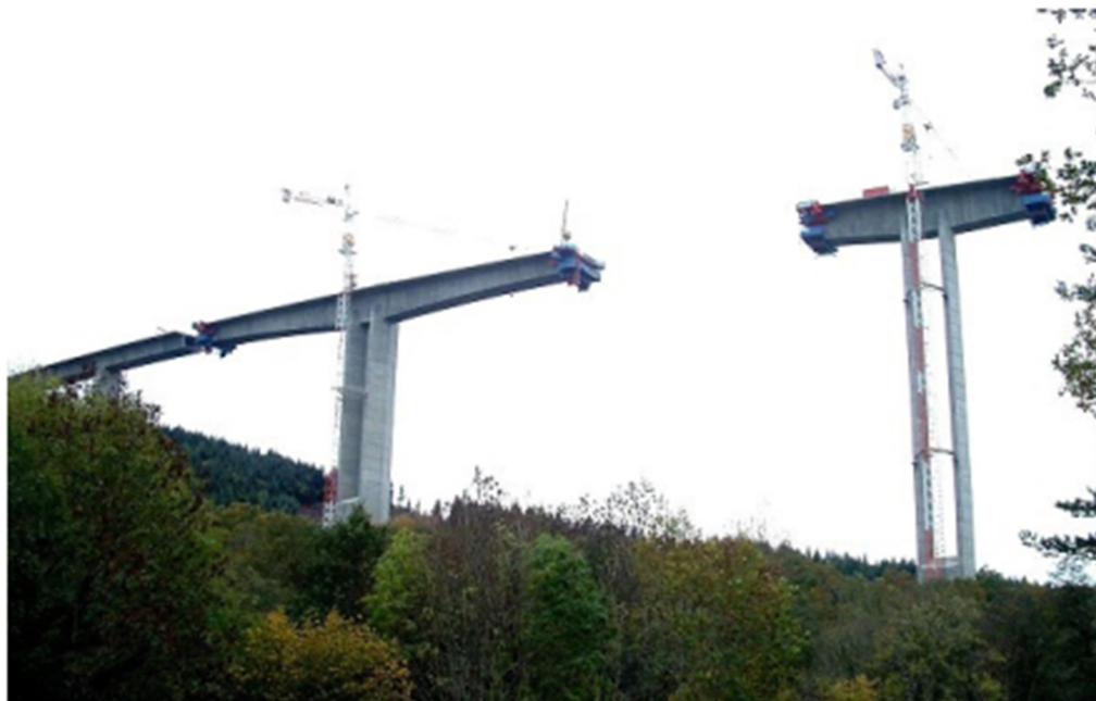
Figure 1.51. Viaduc construit par encorbellement successif.
