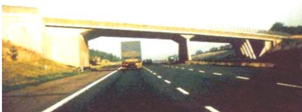
Figure 2.28. Ouvrage hybride disgracieux: la partie gauche est un pont en portique, la partie droite est un pont à béquilles.
