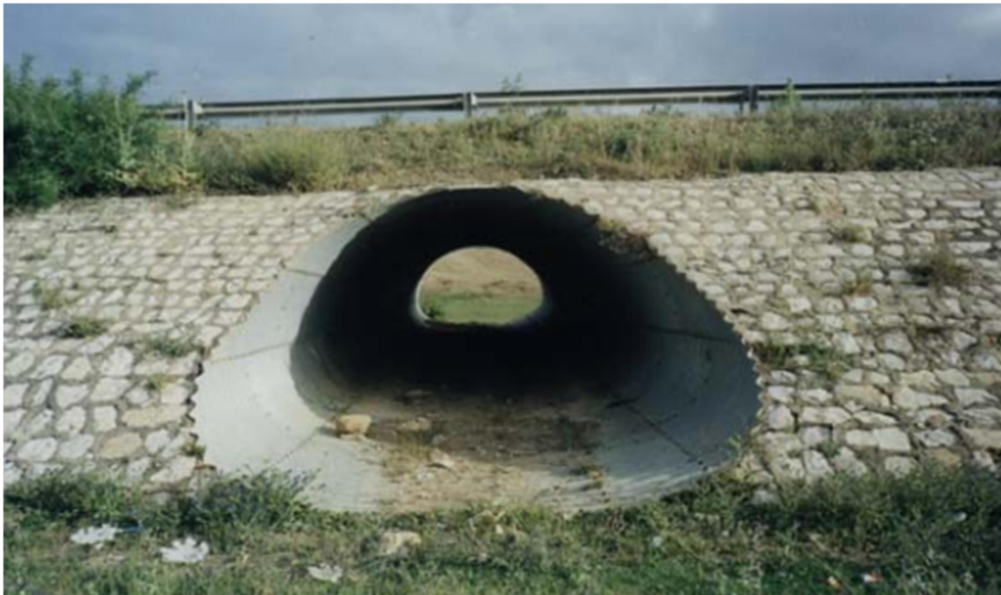
Figure 3.3. Buse métallique.
