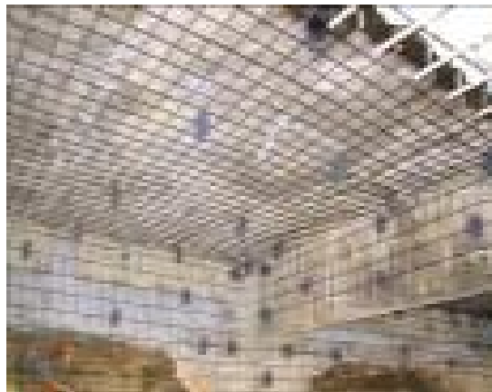
Fig. 5.2: Réalcalinisation du béton par installation du treillis anode sur l'intrados du tablier d'un pont 58
