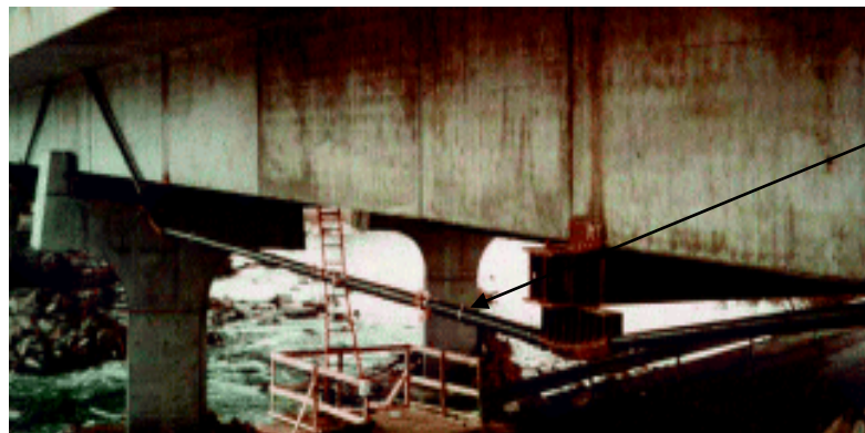
Fig. 5.10: Précontrainte provisoire mise en place pendant les travaux de remplacement de la précontrainte existante 66
