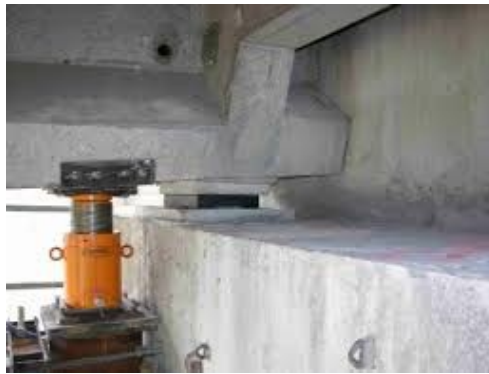
Fig. 4.9: Levage du tablier d'un pont par un vérin posé sur la pile 52
