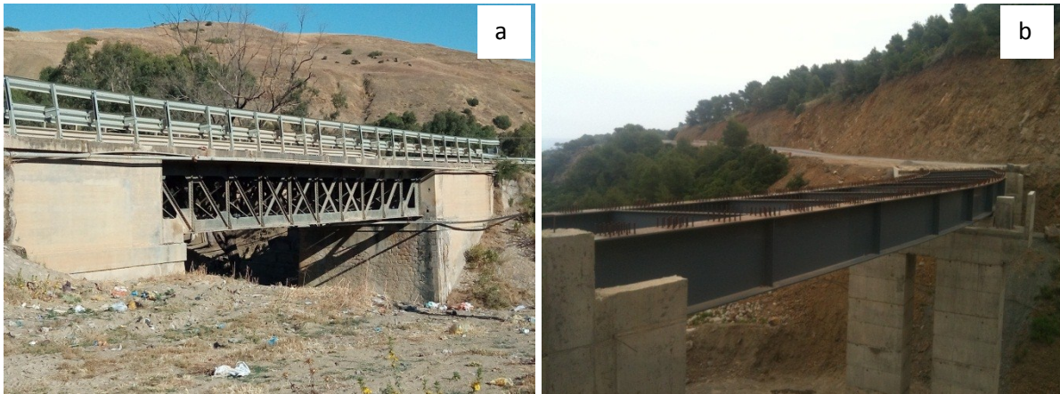
Fig. 3.14 : Pont métalliques en Algérie : (a) à poutres à treillis (sur Oued Ouahran-Chlef ) et (b) à tablier mixte ( Beni Haoua-Chlef ) 31
