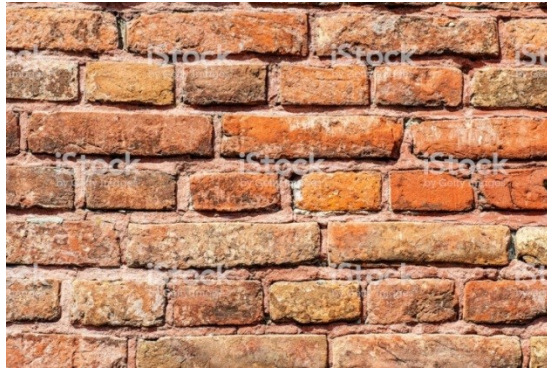
Fig. 3.5 : Mur construit en brique 23
