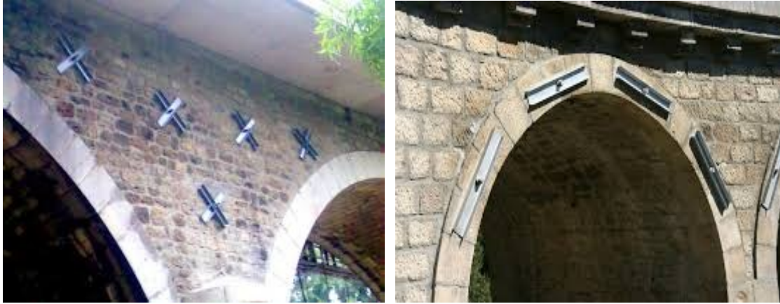
Fig. 5.17: Stabilisation des tympan et de la voûte d'un pont en maçonnerie par ancrages 72
