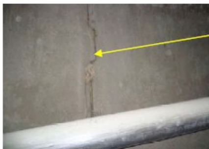
Fig.3- encochements mettant en évidence la préfabrication des voussoirs (visibles sur la figure à gauche)
