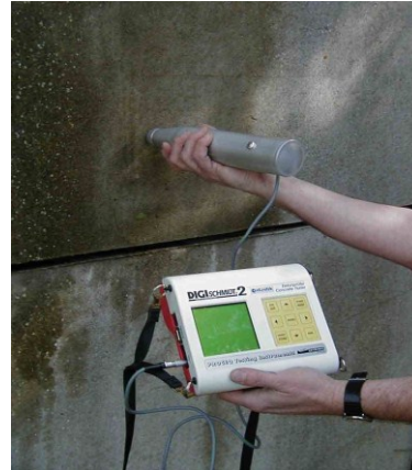
Fig. 4.3 : Utilisation d'un scléromètre sur une paroi de béton 44
