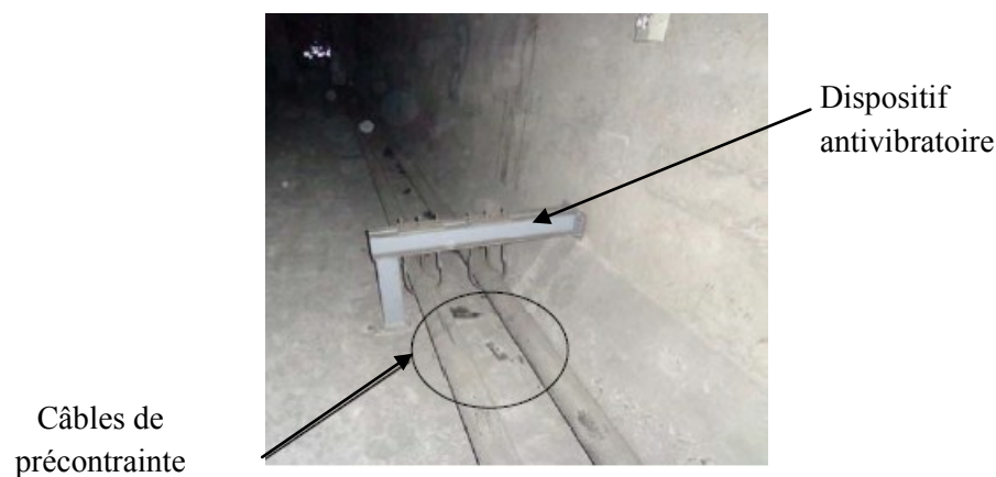
Fig. 5.5: Renforcement par précontrainte additionnelle longitudinale d'un pont à caissons sur le Rhône (France) 62
