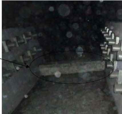
Fig.7- Socles d'ancrage de la précontrainte additionnelle
