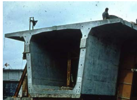
Fig.3- encochements mettant en évidence la préfabrication des voussoirs (visibles sur la figure à gauche)
