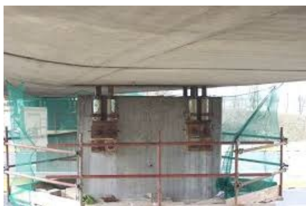
Fig. 5.11: Relevage par vérins plats du tablier d'un pont 67
