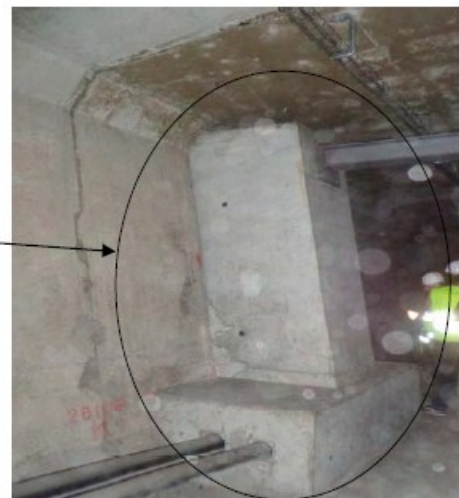
Fig.9 – Massifs en béton armé servant de déviateur de câbles et de socle d'ancrage
