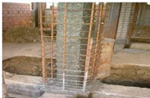
Figure 4.11 : Chemisage d'un poteau.
