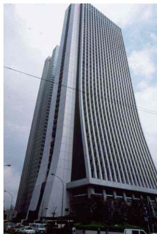
Figure 2.21 : Tour Trans America sans dommage (séisme de Loma Prieta 1989) [24].
