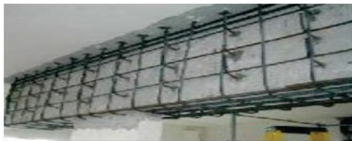
Figure 4.10 : Chemisage d'une poutre.
