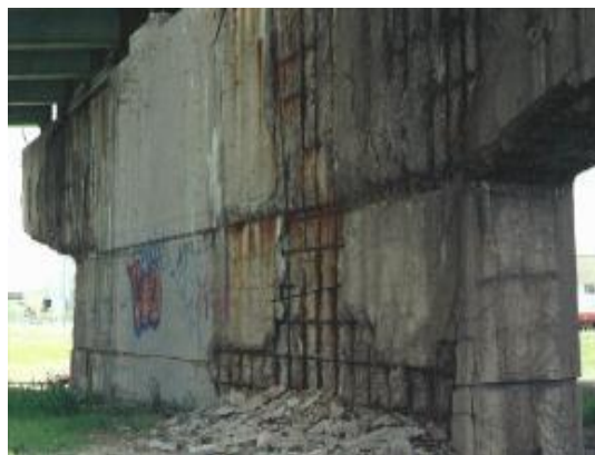
Figure 1.12 : corrosion par piqûres liées au chlorures.
