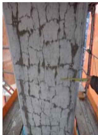
Figure 1.14 : Phénomène d'alkali-réaction.
