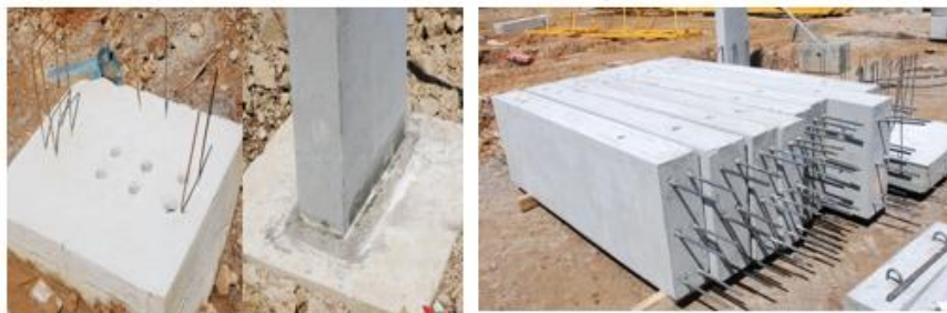
Figure 4.19 : Exemple de scellement par l'ajout de nouveaux poteaux.
