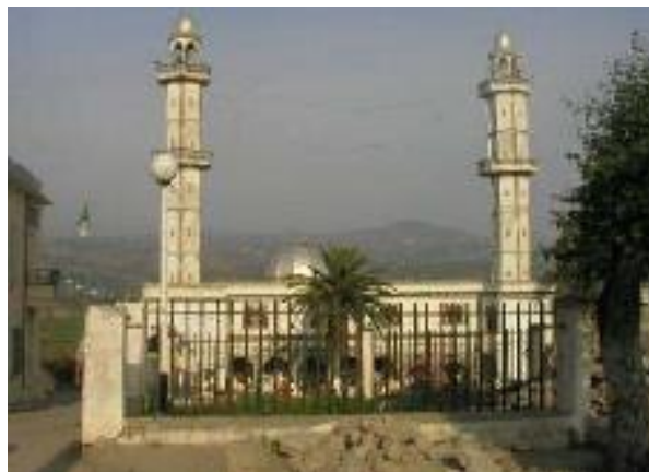
Figure 2.19 : Ville de SIDI DAOUD, Boumerdes 2003. Mosquée sans dommages car les minarets sont indépendants de la structure principale [24].
