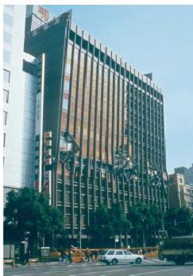
(g) Séisme Kobe 1995
