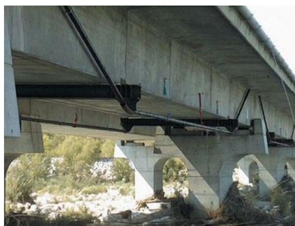
Figure 4.21 : Gaine de précontrainte additionnelle.
