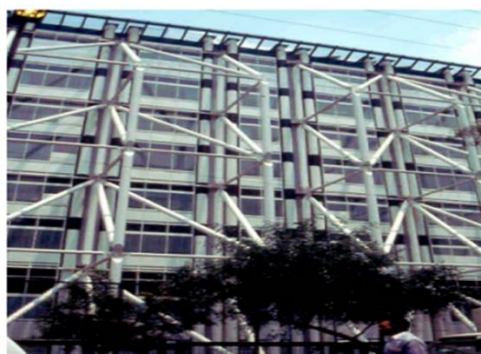
Figure 4.20 : Renforcement par treillis tubulaires [9].
